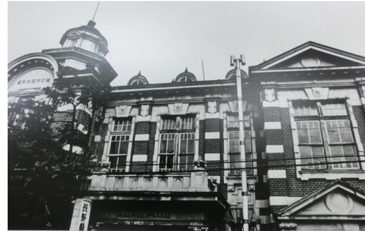
A 長野電燈(株)が開業 明治 30 年(1887)5 月 茂菅に発電所が建設され会社設立から 1 年後の明治 31 年 5 月、長野に初めて電灯がともった。
